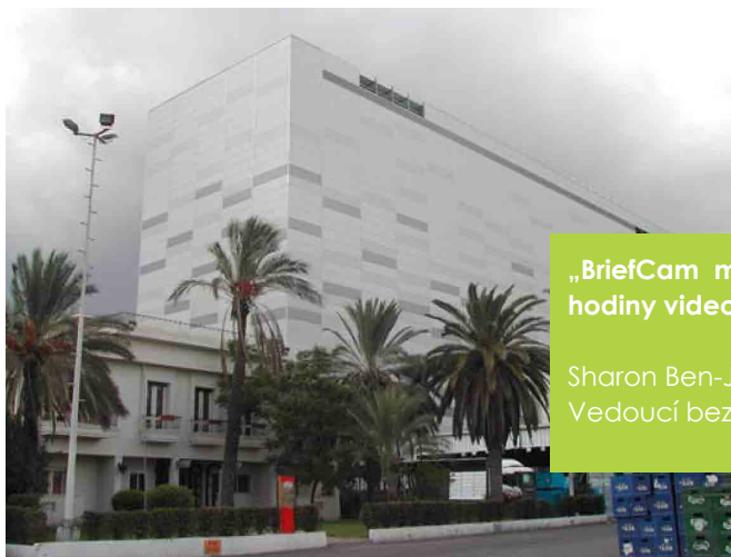
V novém, plně automatizovaném logistickém středisku bude nainstalováno minimálně 100 bezpečnostních kamer.
